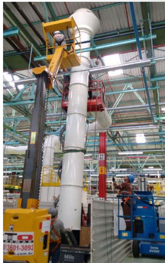
Fábrica de latinha de alumínio
