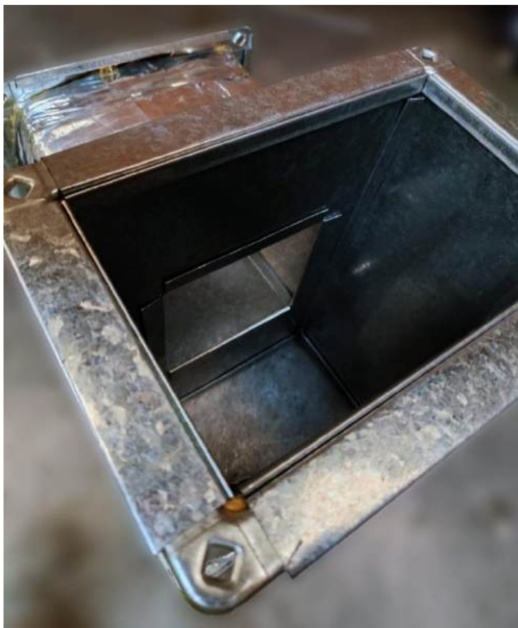
Detalhe da cravação
